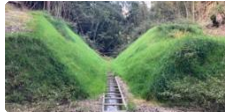
(ため池堤体開削工事の様子 (イメージ))
