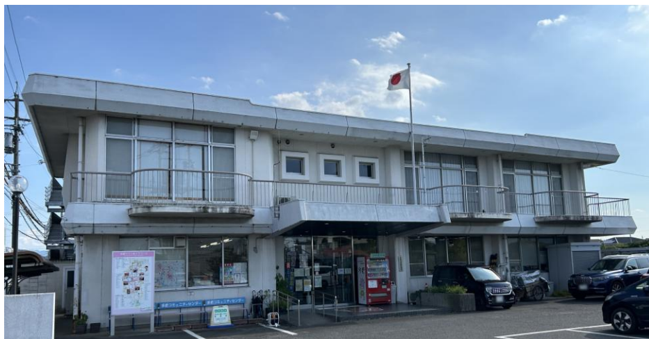
<多肥コミュニティセンター現況写真>
