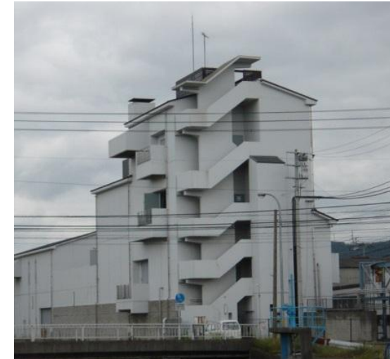
百石ポンプ場
