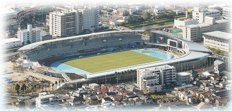
建設中の屋島競技場
