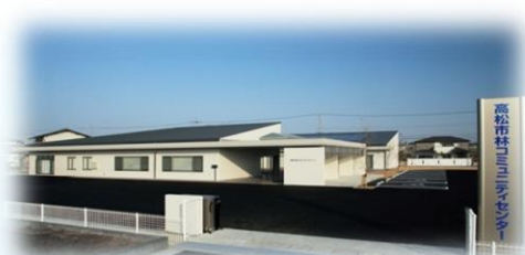
▲竣工後の林コミュニティセンター
