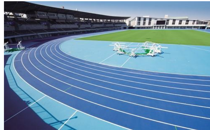
＜屋島レクザムフィールド主競技場の全天候型舗装＞
