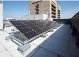
太陽光発電（20kw） 自立運転にも対応
