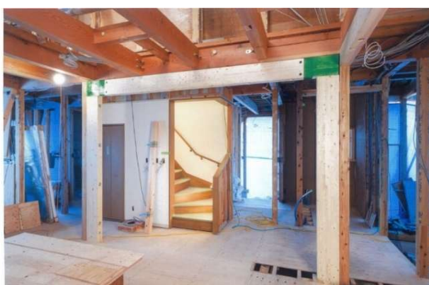
耐震補強工事中
