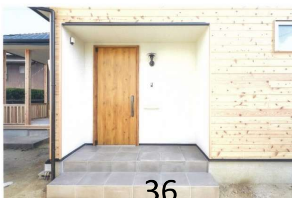
改修後の玄関 * 外壁に木材を使用
