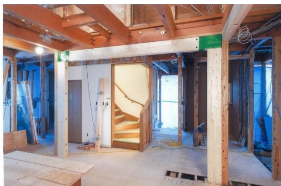
耐震補強工事中
