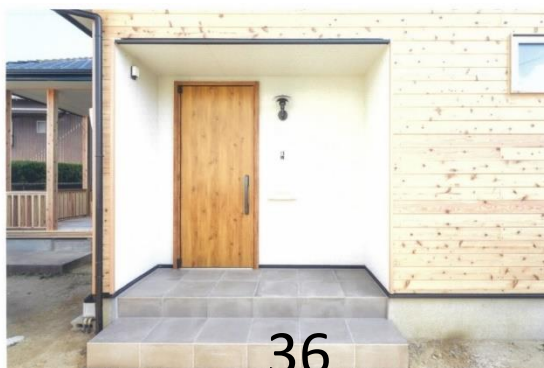
改修後の玄関 ＊ 外壁に木材を使用
