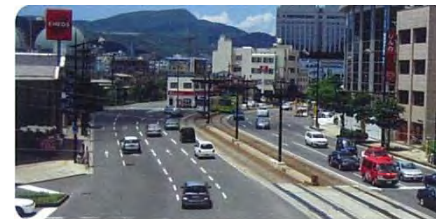
センターポール（長崎電気軌道）
