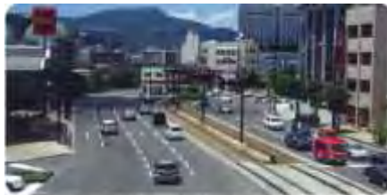
センターポール（長崎電気軌道）
