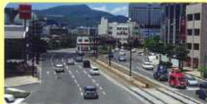
センターポール(長崎電気軌道)
