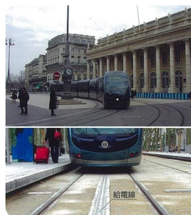
景観に配慮した架線レスのトラム（フランス・ボルドー）
