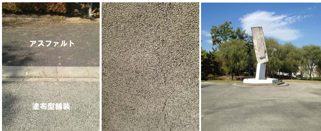
骨材を含んだ塗布型舗装（グレー）の事例
