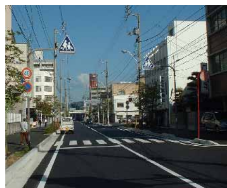
大型灯火式標識 高輝度標示
