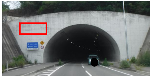
⑥峰山トンネル(東側)
