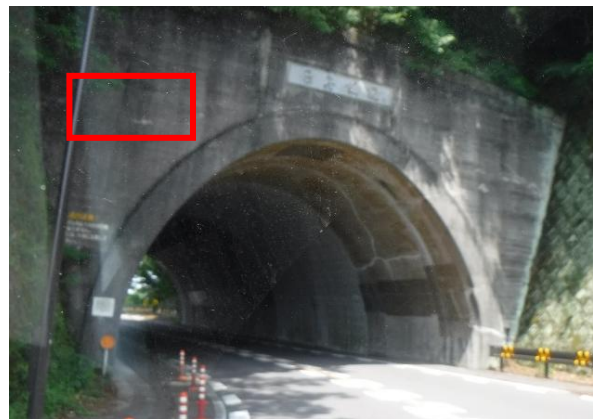
⑦屋島隧道(東側)
