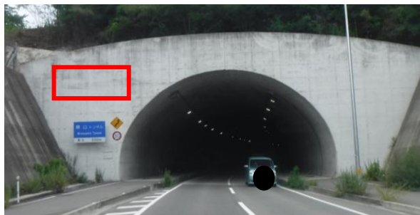
⑥峰山トンネル(東側)
