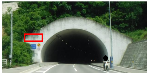
峰山トンネル(西側)
