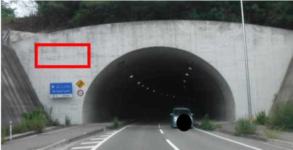
⑥峰山トンネル(東側)
