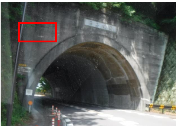
⑦屋島隧道(東側)
