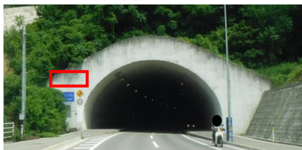
峰山トンネル(西側)
