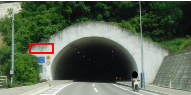
峰山トンネル(西側)
