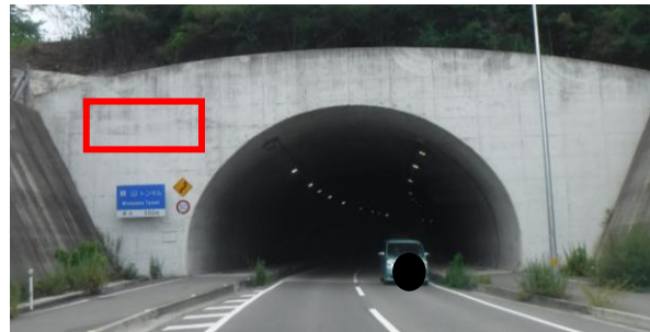
⑥峰山トンネル(東側)
