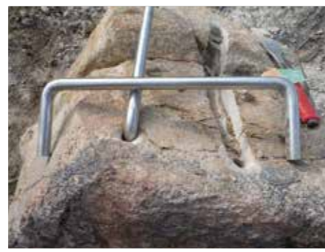
ボルトで繋いだ石材と鋸で補強した石材
