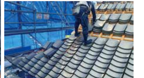
屋根瓦を設置する様子
