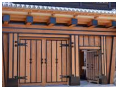
1階部分はケヤキを使用
