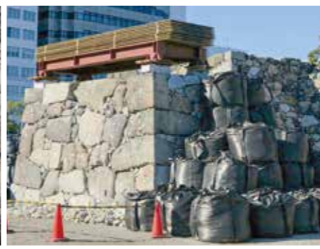
石垣の仮積みと載荷試験
