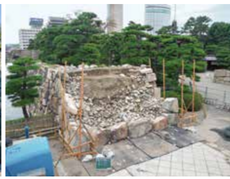
桜御門西側石垣の解体状況
