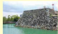
水中の根石から約13mの高さの天守台。この上に3重5階(3重4階+地下1階)建、高さ約26.6mの天守が建っていました。
