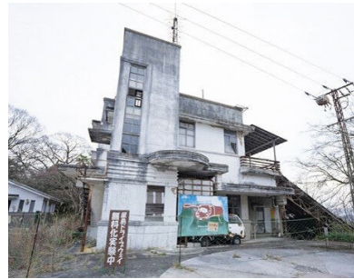
屋島登山ケーブル（屋島山上駅）跡地
