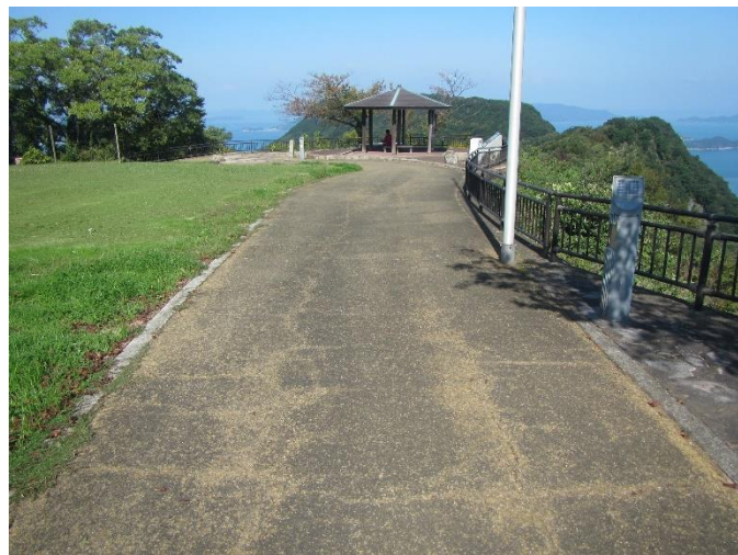
園路舗装(改修前)
