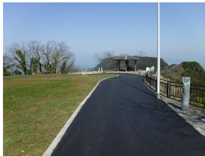
園路舗装(改修後)
