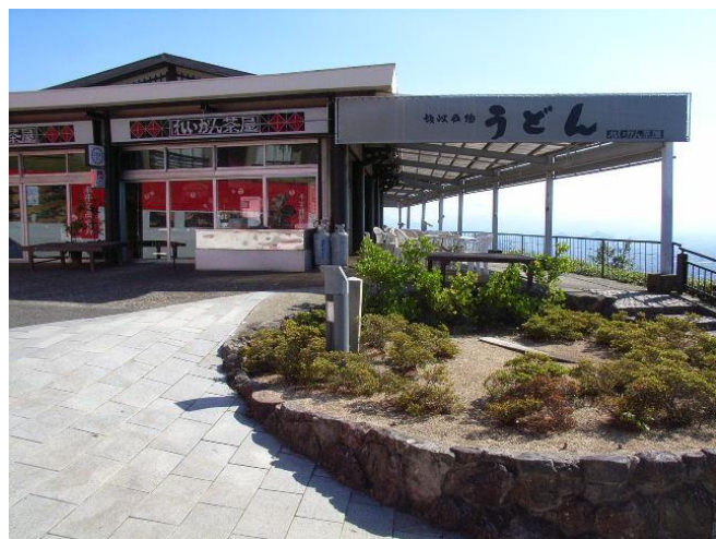
照明灯(改修前)
