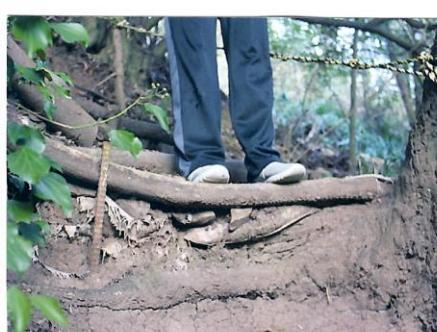
階段の丸太の土が流出
