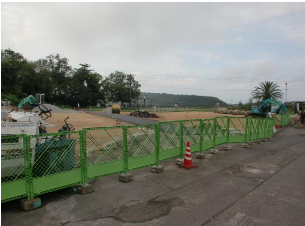
②南東側から撮影
