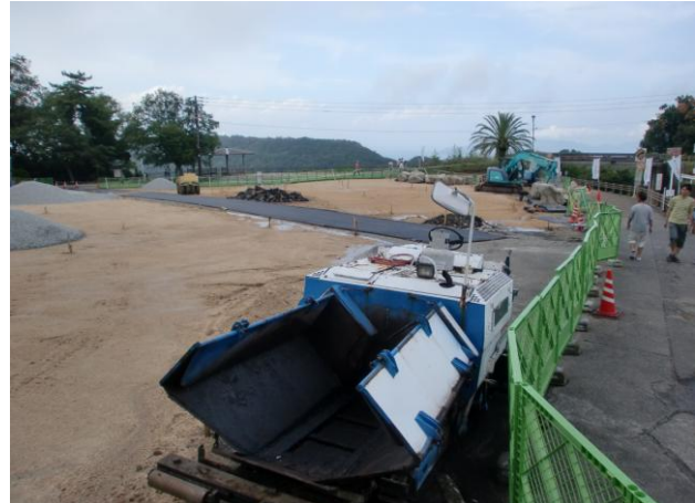
②南東側から撮影
