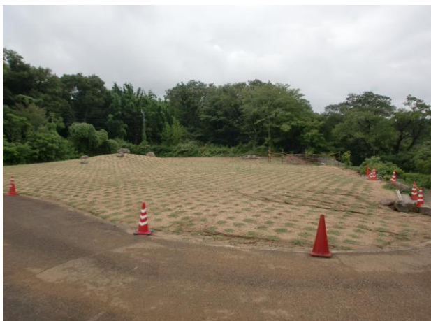
①北東側から撮影
