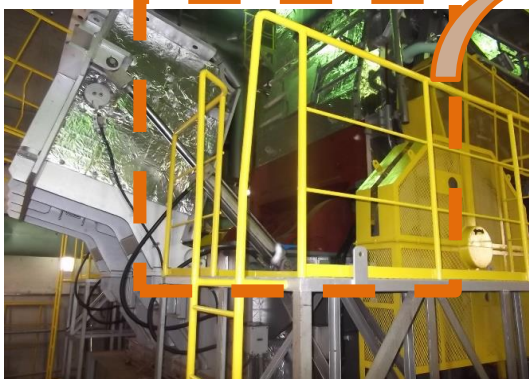
更新後の破砕機(後部ドア 開)
