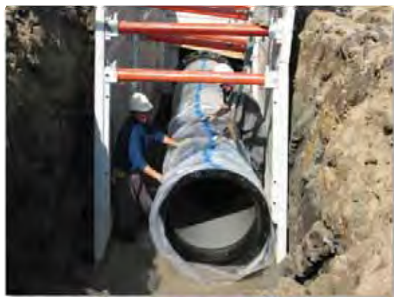
配水管の整備
