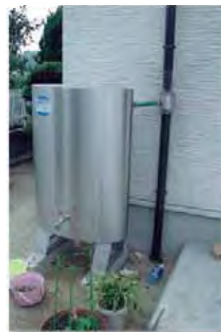
雨水貯留タンク
