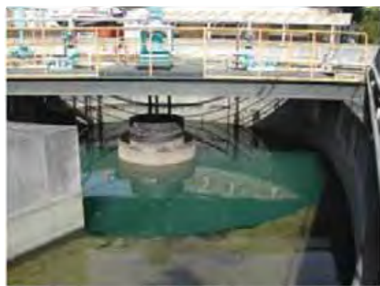
東部ポンプ場 回転円形沈砂池
