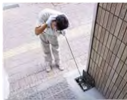
漏水調査（個別音調調査）
