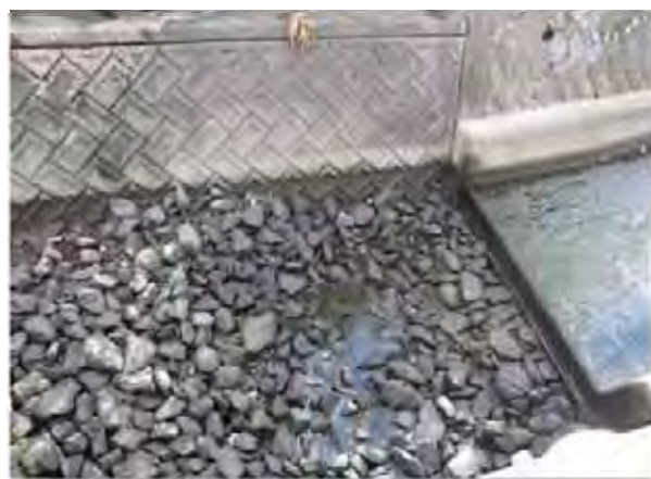
香東川支流の透水性水路底整備（檀紙町）
