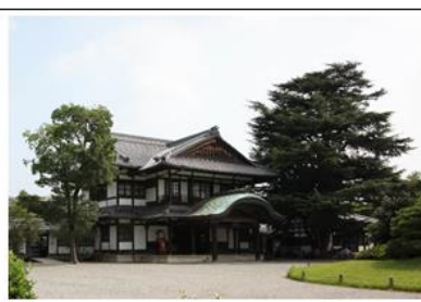
粟林公園 商工奨励館
