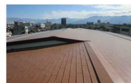
耐久性に優れた屋根材の一例 (カラーガルバリウム鋼板)
