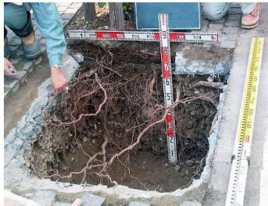
図 4-1-10 基盤内への根系伸長の様子
