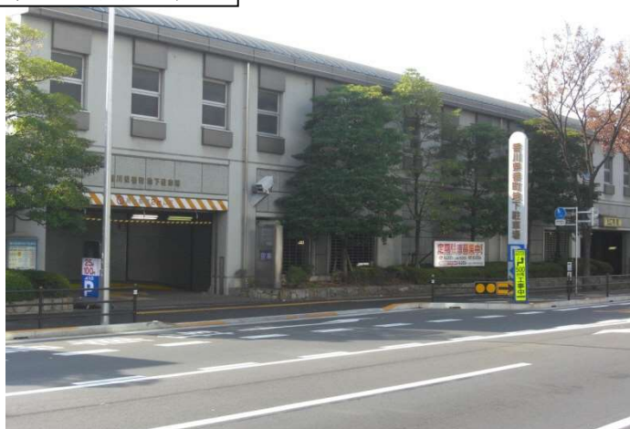
番町地下駐車場
