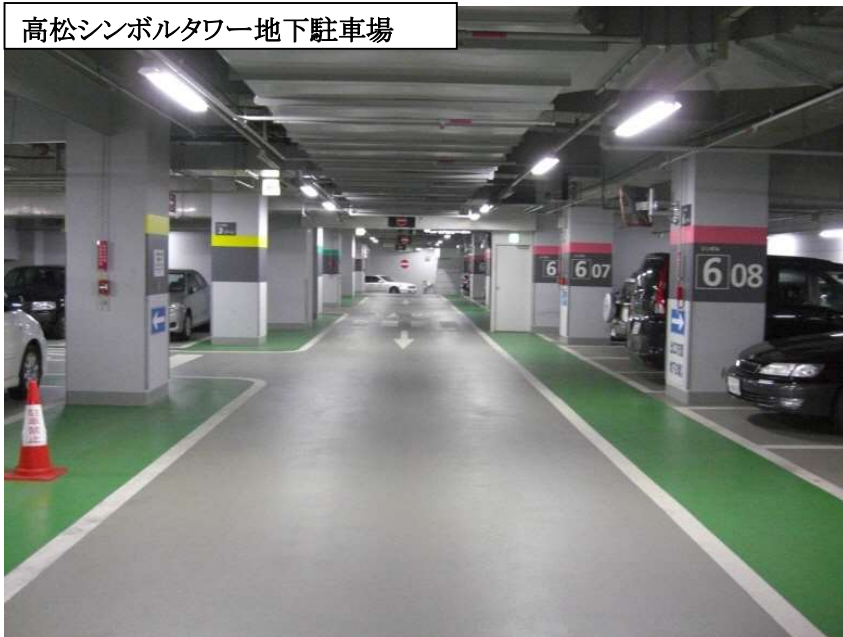
瓦町駅地下駐車場
