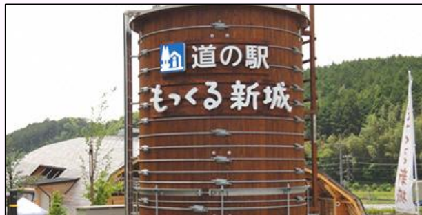
木製受水槽 道の駅もっくる新城〔愛知県新城市〕 (出典:日本木槽木管株式会社 HP)
