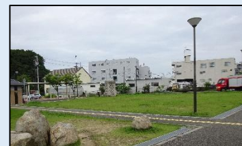
地下埋設の貯水槽
