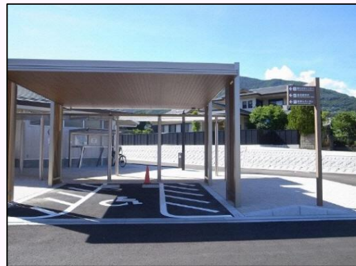
屋根のある車いす使用者用駐車場 道の駅みまの里〔徳島県美馬市〕
