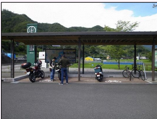
屋根のある二輪車、自転車駐輪スペース 道の駅四万十とおわ〔高知県高岡郡四万十町〕
