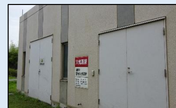
自家発電設備〔約25 ㎡〕
