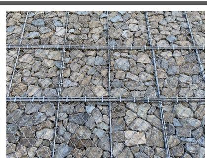
擁壁の整備では、塩江地区に見られる「石積みの田畑」や「川の護岸」といった、塩江らしい「郷土の風景」を大切に、コンクリート擁壁ではなく、石積みのイメージを想起させる「石詰め<sup>じゃ</sup>の蛇かご擁壁<sup>ようへき</sup>」を採用しました。
