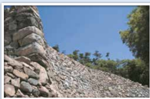
古代山城屋嶋城跡城門遺構整備事業
