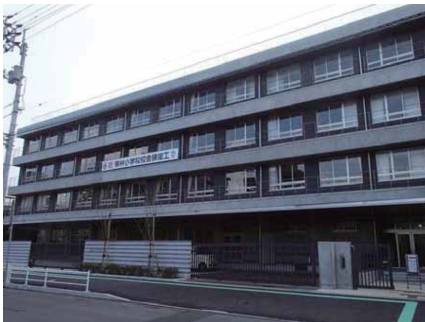
栗林小学校新校舎(平成29(2017)年12月完成)
