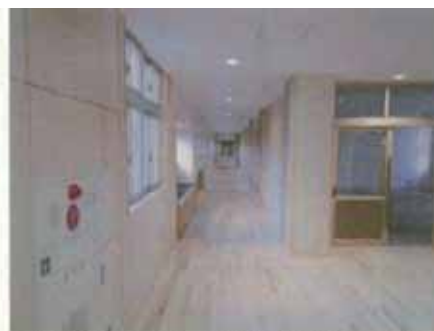
改修後) 廊下の壁を一部撤去し多目的スペースを整備
