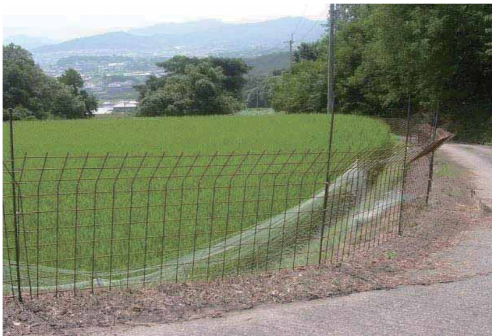
進入防止柵の設置
