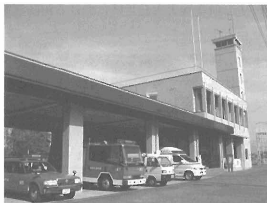
西消防署 綾川分署
