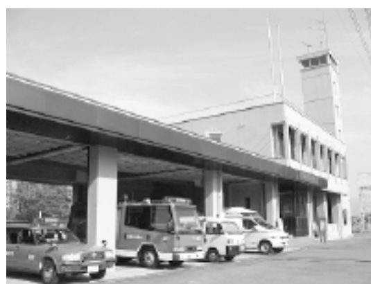
西消防署 綾川分署
