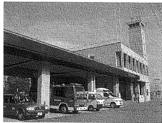
西消防署 綾川分署
