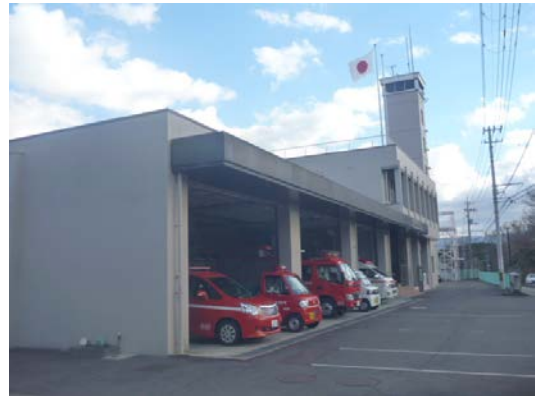
西消防署 綾川分署
