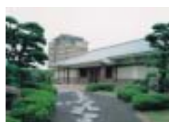
讃岐国分寺跡資料館 (外観)
