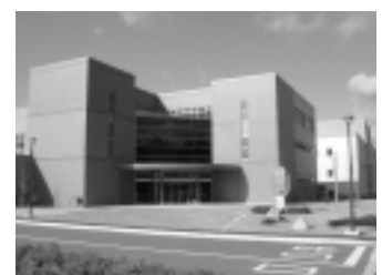
南部広域クリーンセンター
