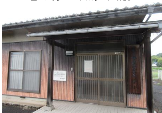
香川町丸山地区構造改善センター
