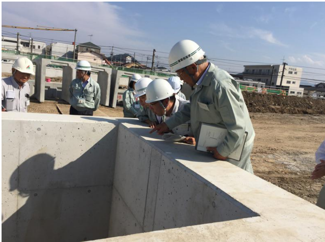
工事現場における実地調査風景（平成27年10月9日撮影）
