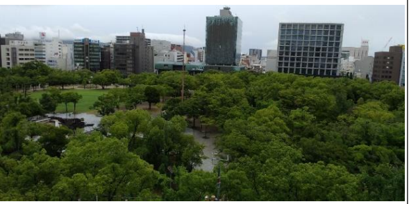
【樹木】 樹木が壁となり、まちと公園が分断。 全体的に暗く、近寄りづらい雰囲気。 衛生害虫被害など
