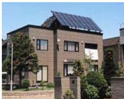
太陽光発電システム
