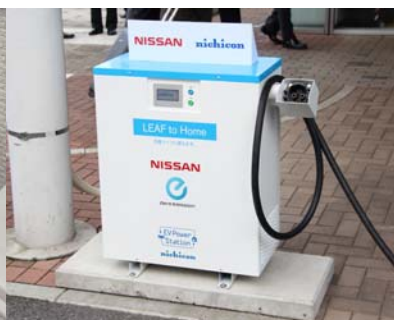
電気自動車充電設備
