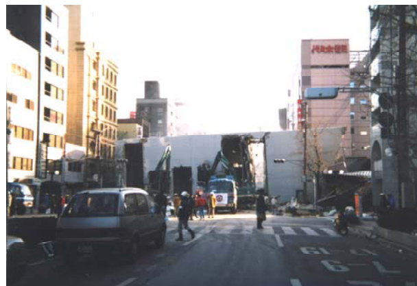
道路を遮断した倒壊建築物(阪神淡路大震災)
