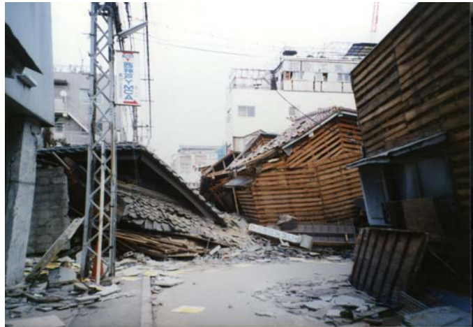
倒壊した木造住宅（阪神淡路大震災）
