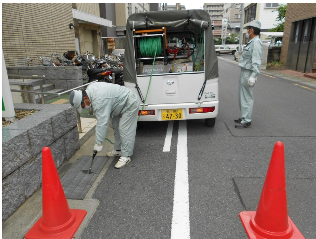
【用排水路への消毒作業】
