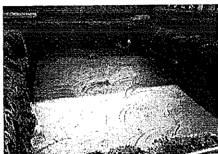
捨コンクリート打設状況
